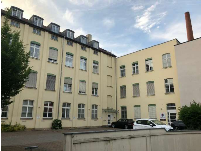
Rückseite mit Parkplatz
