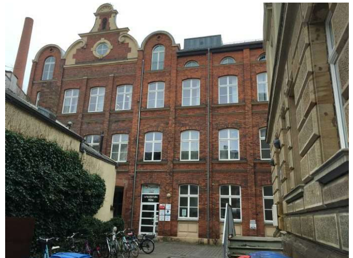
Ansicht von der Strasse
